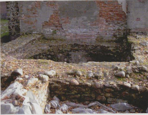
Abb. 7: Fundamente des abgebrochenen Westturmes in Dähre. Deutlich erkennbar die älteren Mauern eines Rundturmes: Foto: Archiv Matthias Friske.
