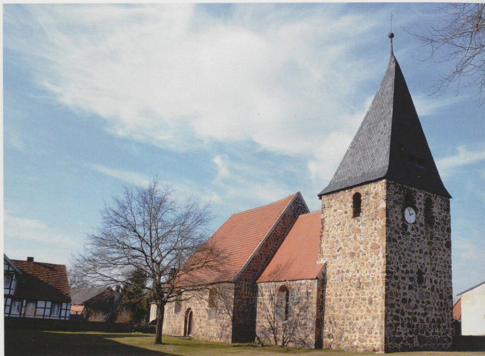
Abb. 10: Dorfkirche von Wallstawe. Chorquadratkirche des 13. Jahrhunderts, der später ein Ostturm angefügt wurde. Foto: Matthias Friske.
