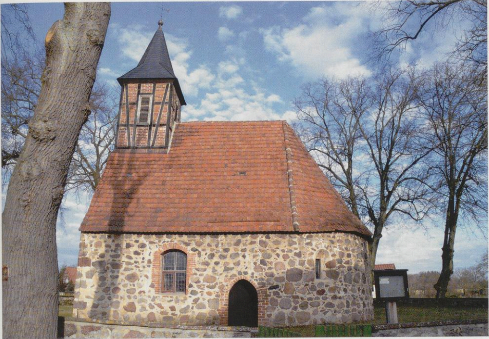
Abb. 6: Dorfkirche von Hohenlangenbeck von Süden (Chorkirche mit halbrundem Ostschluss). Foto: Matthias Friske.
