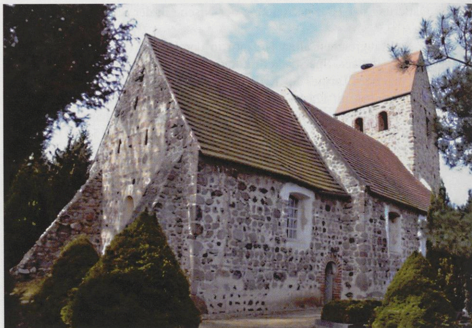
Abb. 3: Dorfkirche von Groß Chüden von Nordosten (Chorquadratkirche mit eingezogenem Turm). Foto: Matthias Friske.
